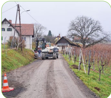
Neue Aunbergstraße Wir starten den zweiten Bauabschnitt. Seite 5
